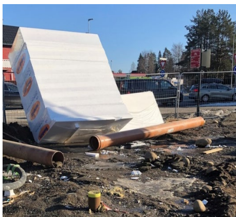
EPS på byggeplass lagret i pall, stablet mot gjerdet med mye småbiter og smuler rundt.
