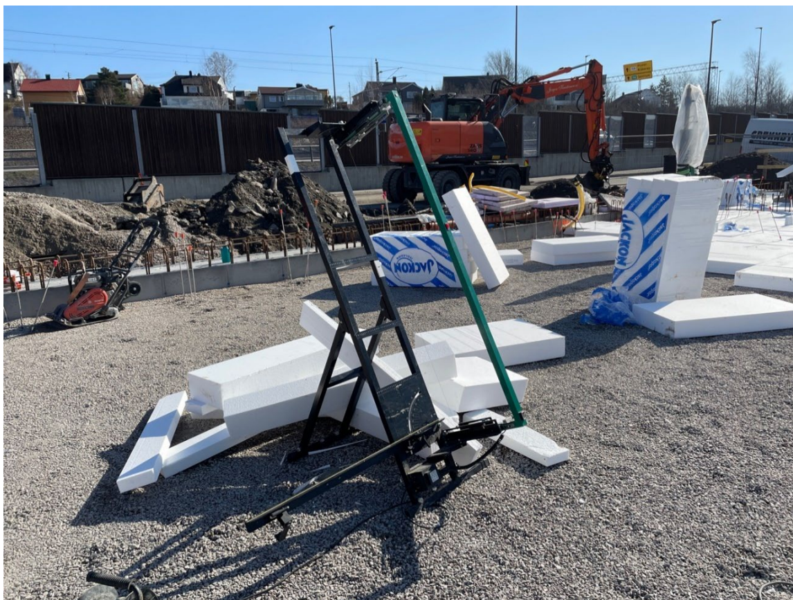
Skjærebord med glødetråd på egen kappetasjon på byggeplassen.
