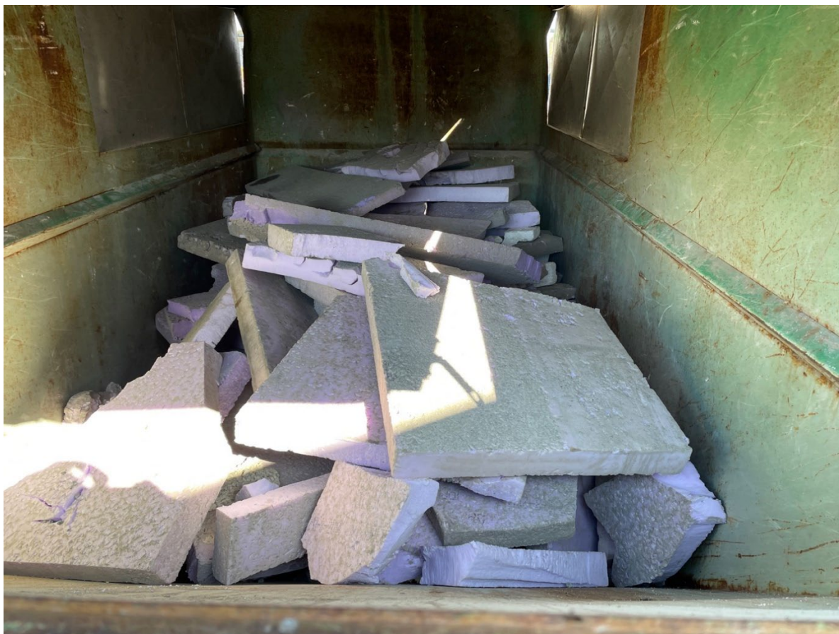
Egen avfallskonteiner til EPS og XPS på byggeplass.
