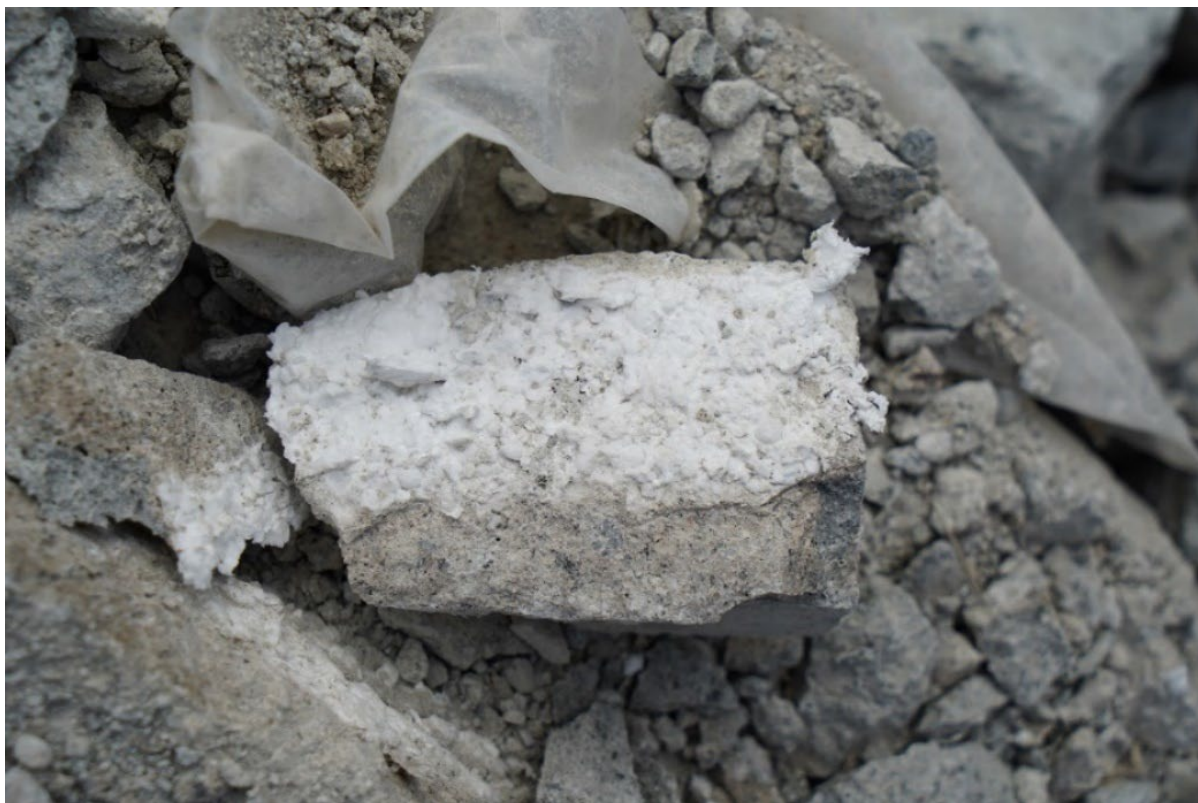
EPS støpt inn i betongen.
