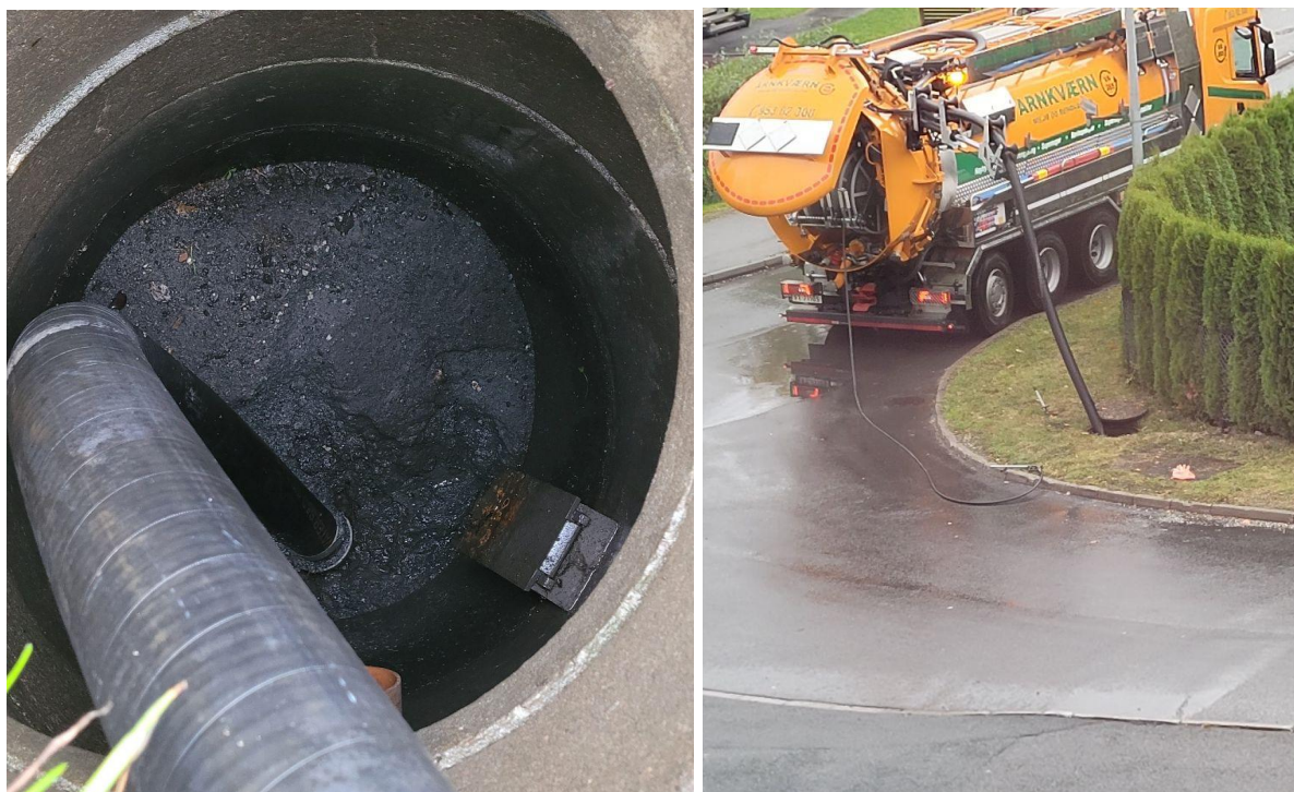
Bildetekst: Bilder fra spyling av sandfang i Bærum kommune.
